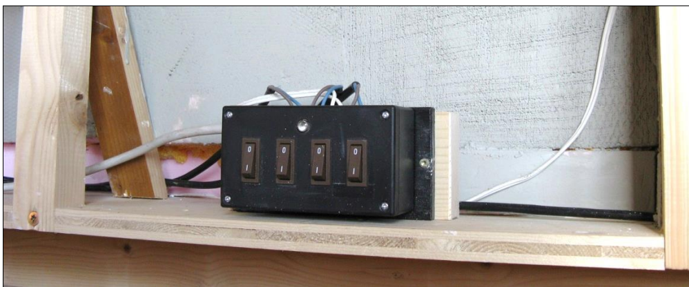
Mit dem Schaltkästchen sind vier Lampen getrennt schaltbar.
